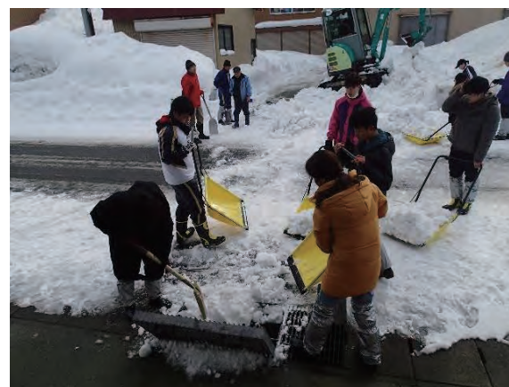
(f) 県道沿いの宅地内の雪を流雪溝に流す
