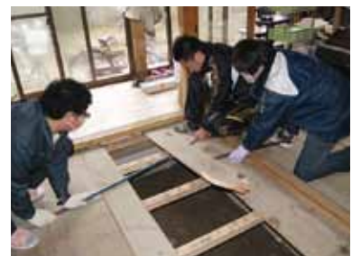
家屋の床下調査の様子
