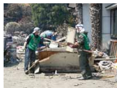
瓦礫撤去作業
