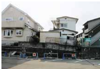
東日本大震災の被災事例。造成宅地では、地盤変状により建物が傾斜・変形するケースが多く見られた。
