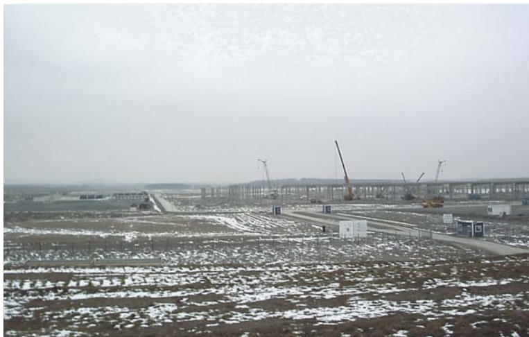
向こうの山まで続く広大なトヨタ・コリン工場の建設現場（03年2月）
