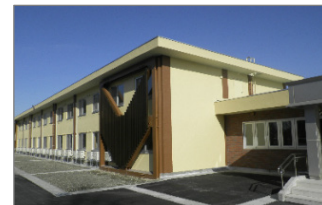
啓明寮 (H24改修後)
