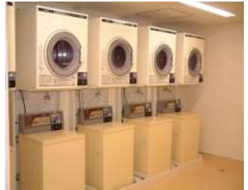
せんたくしつ 洗濯室 Laundry room
