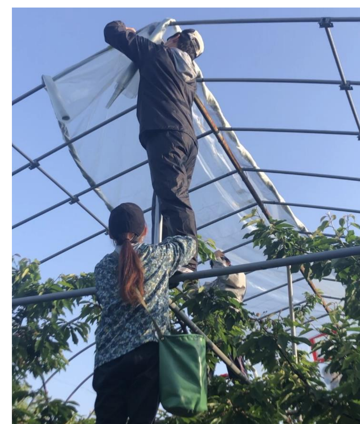
オウトウ雨よけハウスのビニル張り作業の様子
