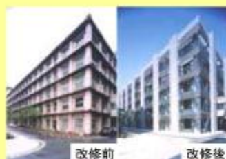
大阪大学（基礎工）校舎改修
