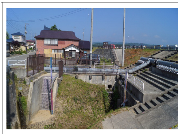
写真-7 蔵岡地区の最上川排水施設
