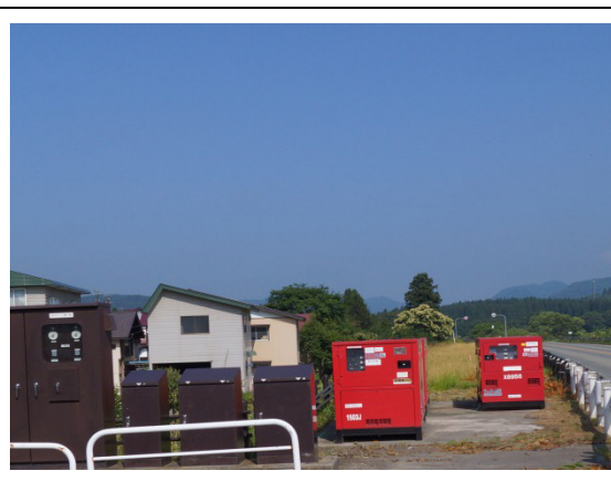
写真-8 蔵岡地区の排水施設用発電機
