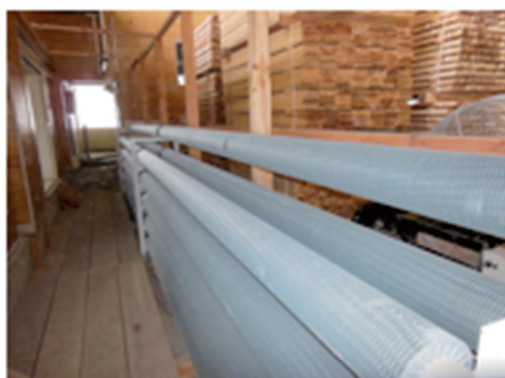
熱湯パイプライン
