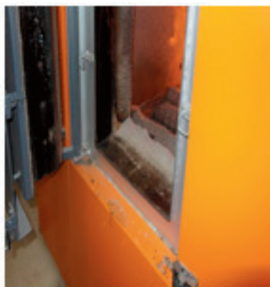
梅里苑チップボイラー本体
