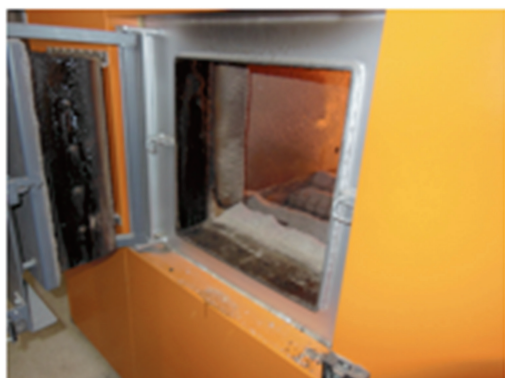
チップボイラー本体
