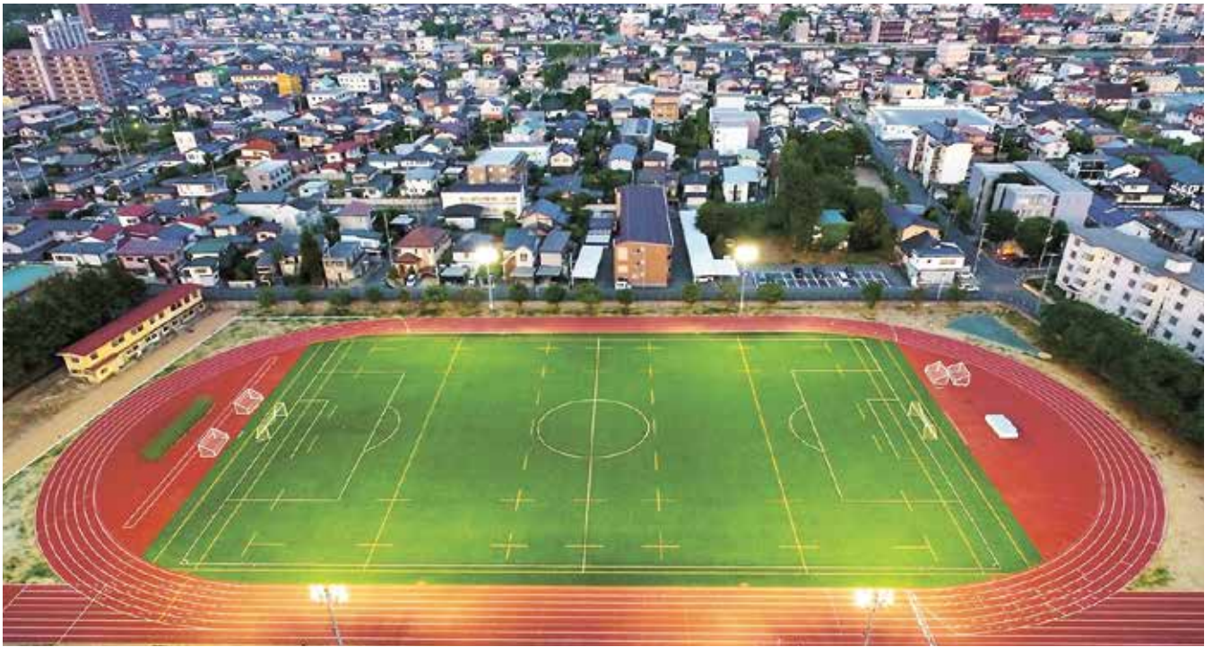
ドローンにて上空から撮影した新グラウンド全景
