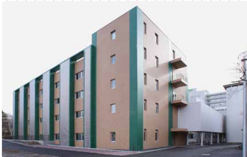
山形大学がん研究センター (2014年施工)
