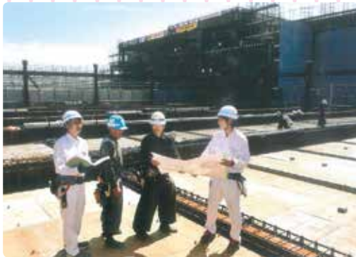
東桜学館体育館 施工時の様子
