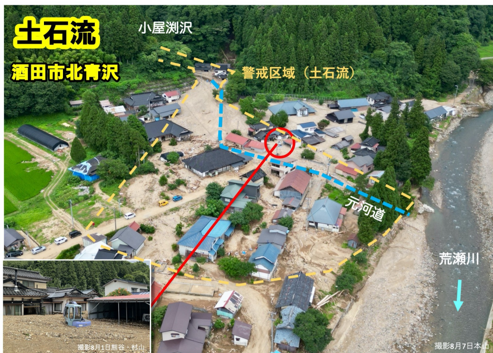
酒田市北青沢小屋沢では、小屋沢からの土石流によって集落全体に土砂が流入、堆積した。
