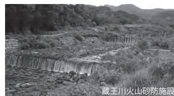
蔵王川火山砂防施設
