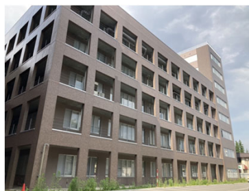
▲タイル剥落防止改修
