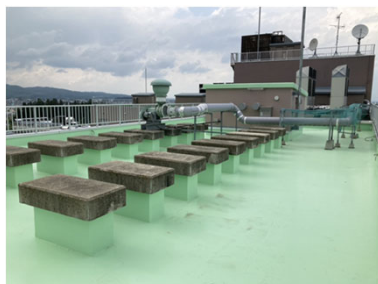
▲屋上防水改修
