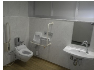
工学部図書館の多目的トイレ 節水型衛生機器の設置 (米沢・工学部)
