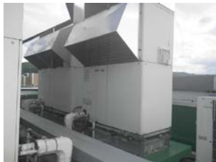
空調設備更新で新たに屋上へ新設された空調室外機 (小白川・理学部)
