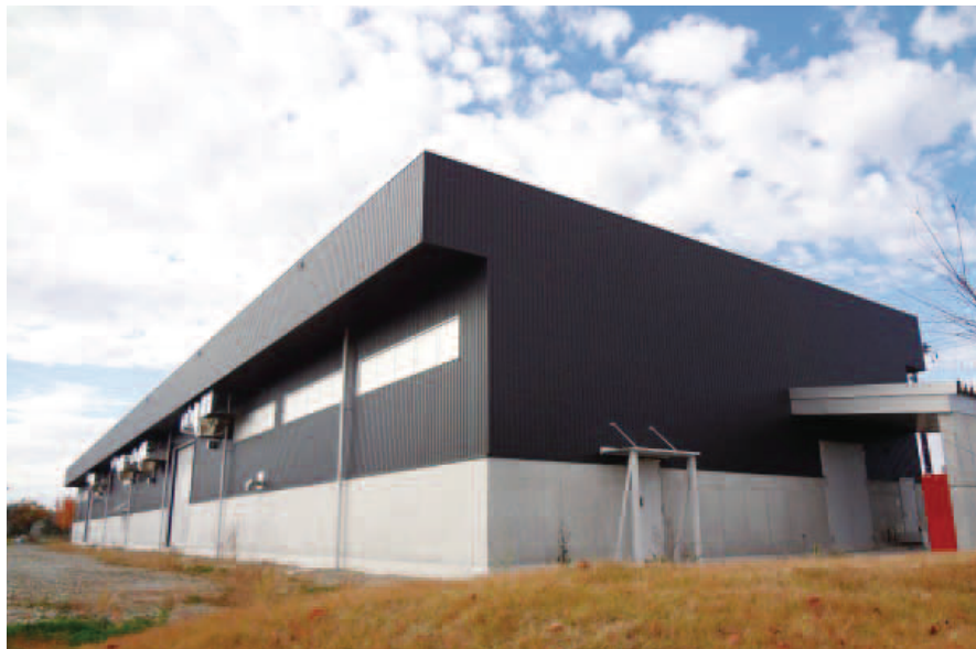
工学部 蓄電デバイス開発研究センター 外観
