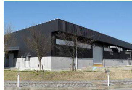
セパレーターフィルム製造 パイロットプラント
