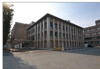
文系総合研究棟(H25改修)
