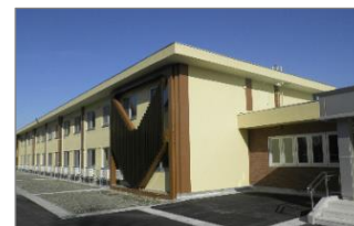
啓明寮(H24改修後)
