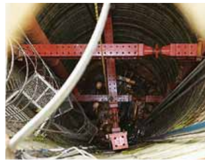
かなり深層で発生した今回の地すべり。より深い地層から地下水を排除するためにボーリングが進められている現場。
