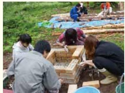
3 焚き火広場にレンガを使った囲炉裏(いろり)を製作。砂利を敷いて踏み固め、レンガを積んでモルタルで接着していく工程は、まるで幼い頃の粘土遊び気分。
