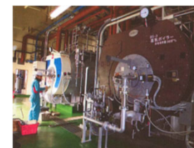
▲ボイラ設備のばい煙測定実施状況（小白川キャンパス）
