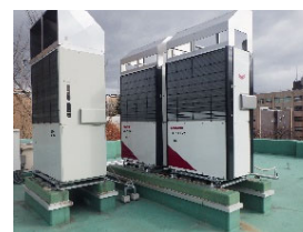
▲完成後（小白川・厚生会館）
