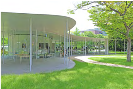
岡山大学 Junko Fukutake Terrace (Jテラス)
