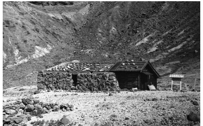
図6 蔵王火山共同研究所正面（南側） 窓以外は石積みで覆われている
