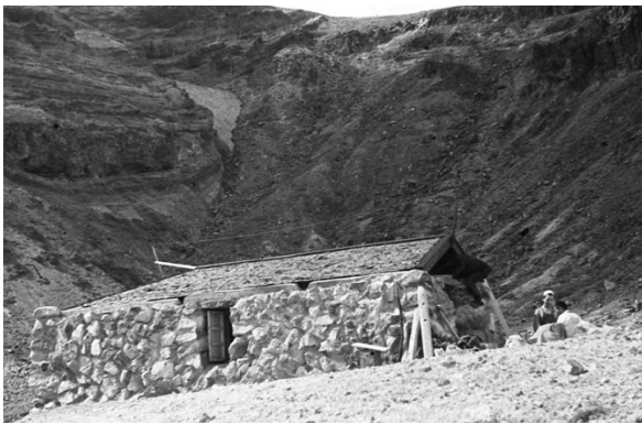
図3 建設中の蔵王火山共同研究所 屋根にラジオのアンテナが張ってある
