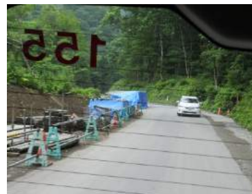
改良工事中の国道347号
