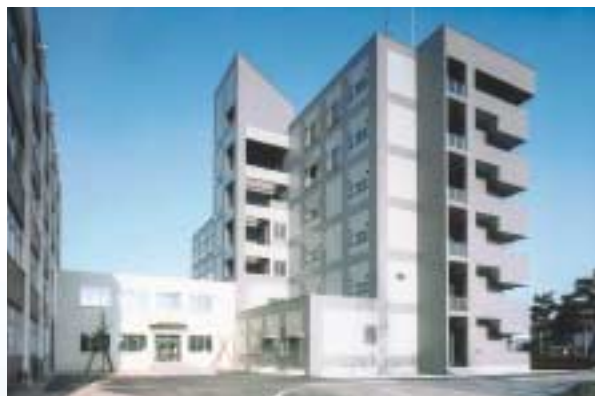
新築された先端教育研究棟
