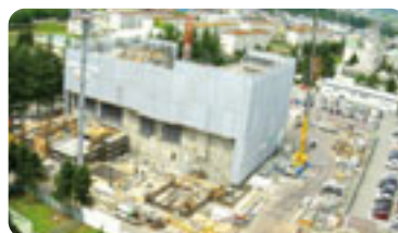
重粒子線 がん治療施設の 建設現場
