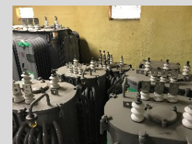
▲PCB廃棄物保管場所（飯田キャンパス） ※写真内の機器は廃棄処理済み
