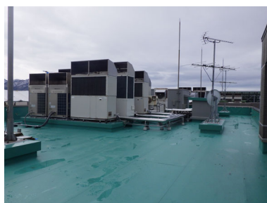
▲屋上断熱防水改修
