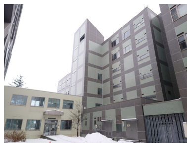
▲タイル剥落防止改修
