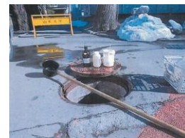
◀排水・貯留槽（小白川キャンパス）
