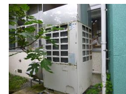
▲第一種特定製品確認 (空調機・附属幼稚園)
