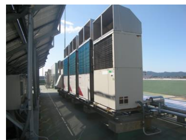
▲空調室外機更新（鶴岡キャンパス）
