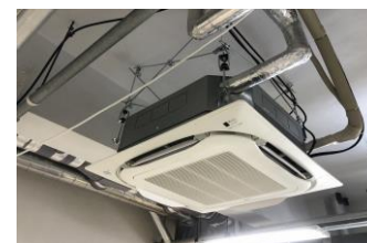
▲空調機更新（米沢キャンパス） 室外機（上）、室内機（下）
