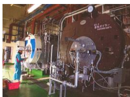
▲ボイラ設備のばい煙測定実施状況 (小白川キャンパス)
