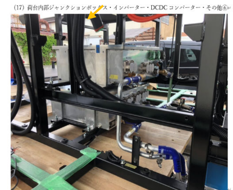
(17) 荷台内部ファンクションボックス・インバーター・DCDCコンバーター・その他⑥
