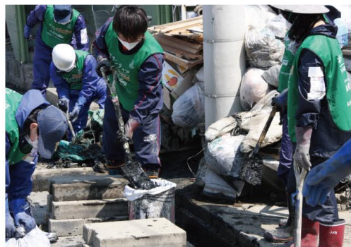
「スマイルエンジン山形」での側溝のヘドロかき出し作業
